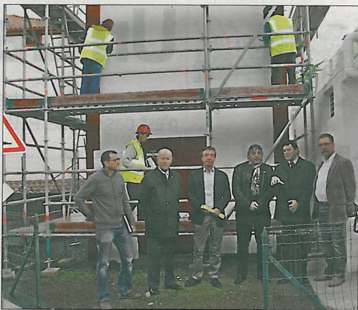
Les représentants d'ERDF, d'Atherbea et de la commune d'Hasparren ont visité le chantier du poste du lavoir. PHOTO J.A.
